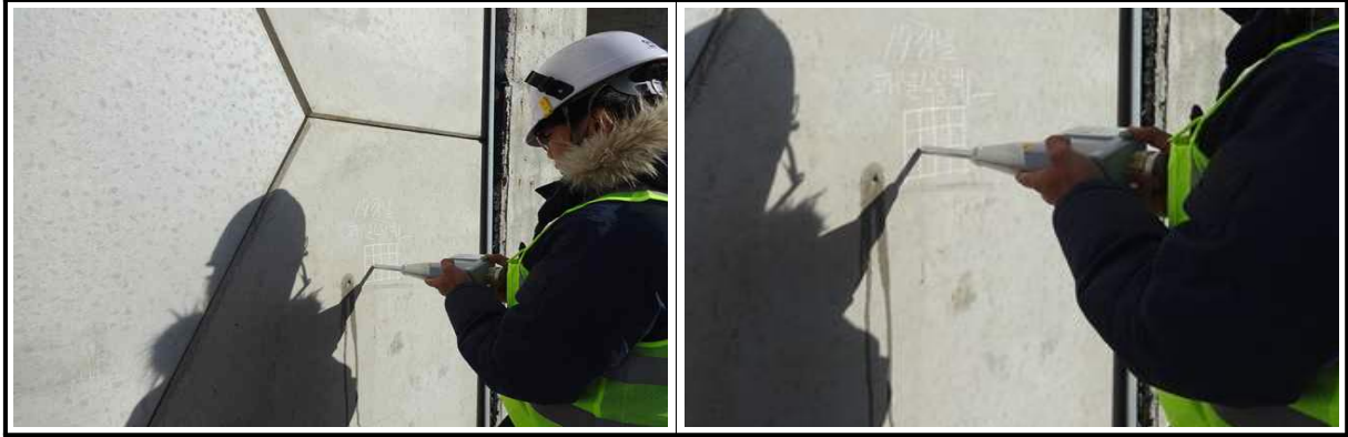
【그림 12.3.6】 슈미트해머를 이용한 반발경도시험 전경
